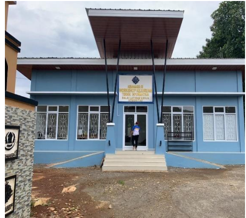
Gedung New Alexandria
