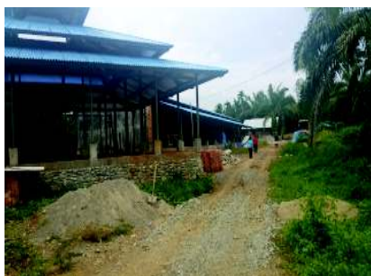
Pembangunan masjid dan kelas hasil infaq guru-guru Darunnajah Pusat
