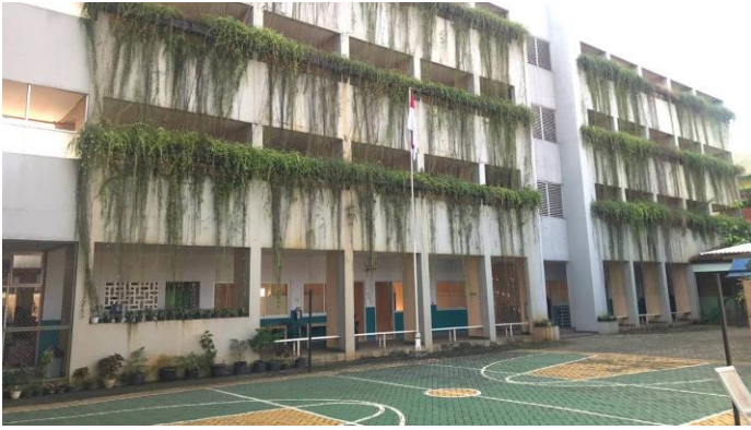
Gedung Asrama Akhwat
