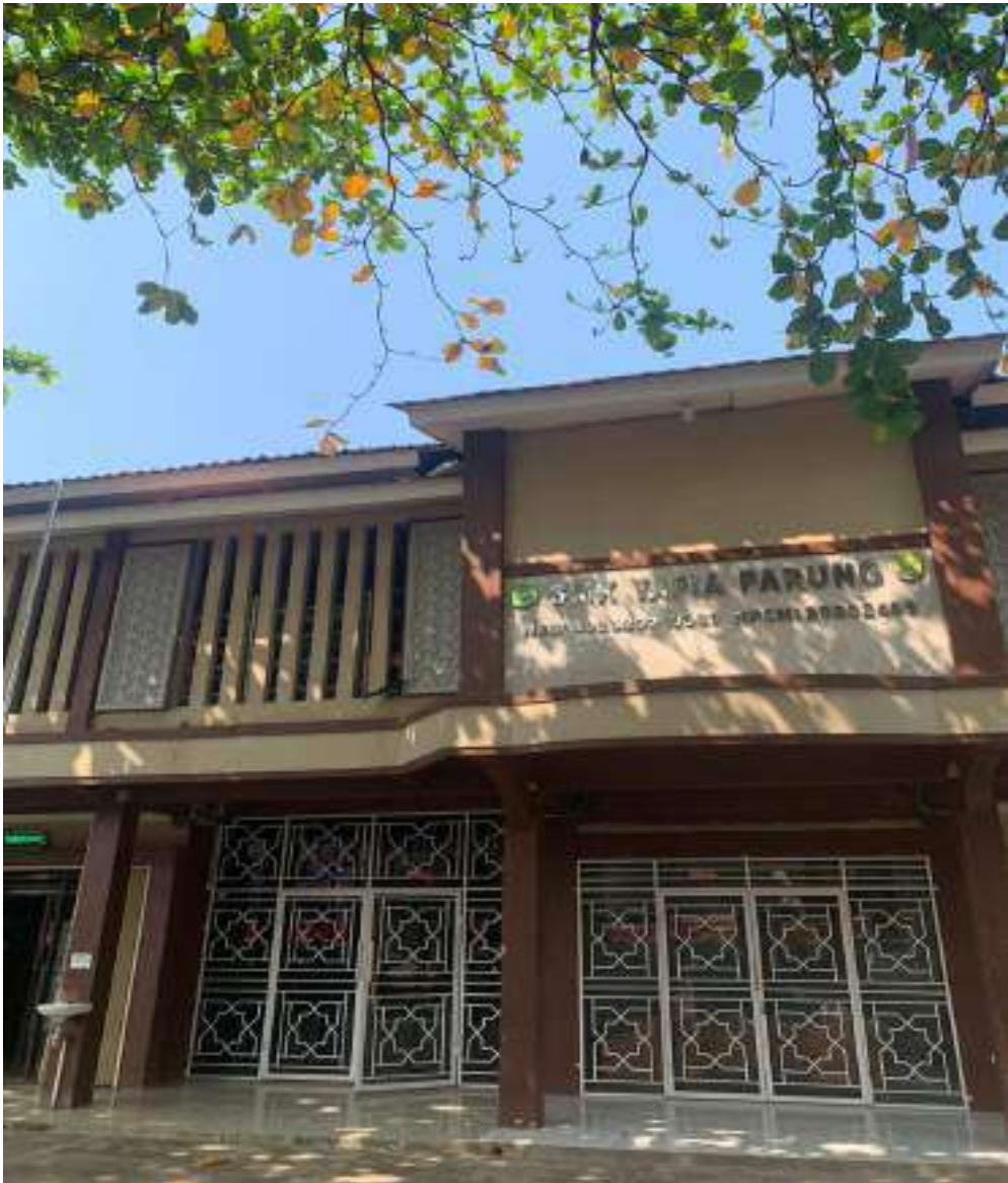
Gambar 1.5 Gedung SMK Yapia
