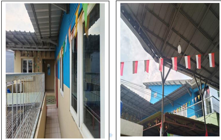
Gambar 4.2 Foto Gedung TK Islam Ad-Dahiriyyah Tampak Atas Lantai 2
